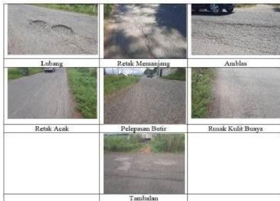
**Gambar 9 Jenis Kerusakan Lapis Perkerasan jalan Unit Sampel 1**
