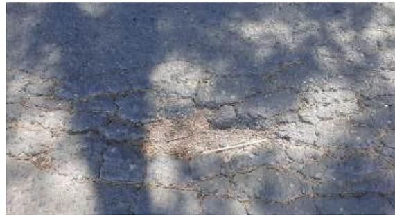
**Gambar 1 Retak Kulit Buaya (*Alligator Cracking*)**
