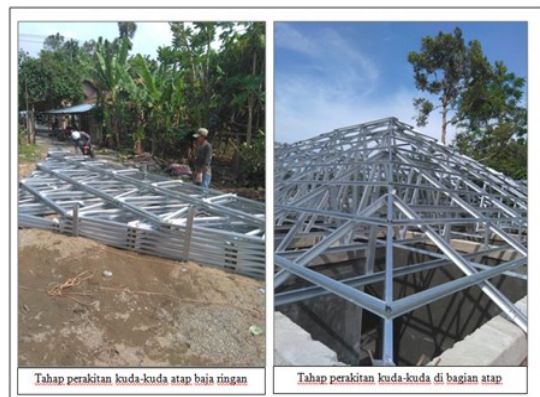
Gambar 3. Tahap Pekerjaan perakitan kuda-kuda atap baja ringan
