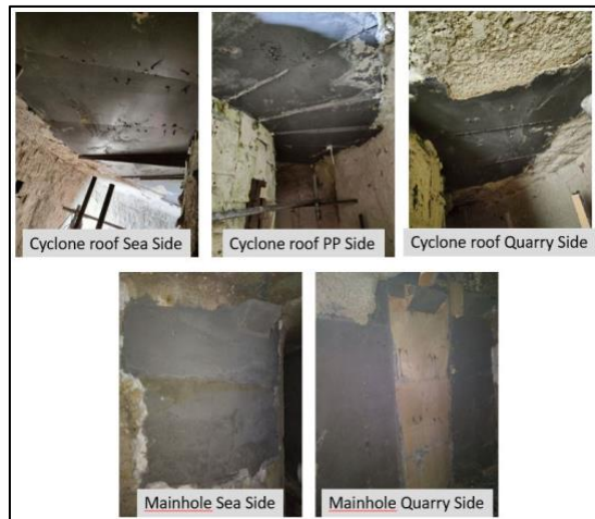
Gambar 10. Hasil pengecoran setelah moulding dibuka
