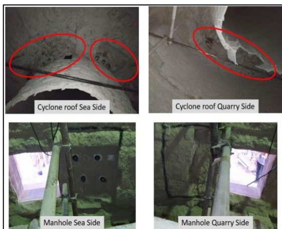
Gambar 1. Hasil inspeksi cyclone 4A
