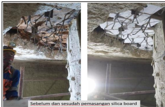
Gambar 7. Pemasangan silica board pada cyclone 4A
