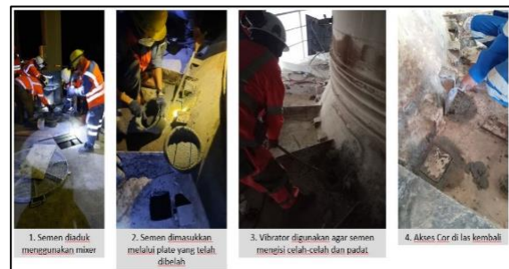
Gambar 9. Aktivitas pengecoran cyclone 4A
